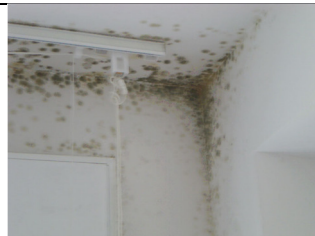
Humedades de condensación por falta de ventilación
