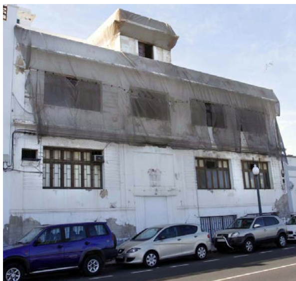
Demolición del edificio. Febrero 2014
